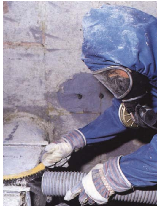
9.attēls. Aizsargapģērbs un individuālie aizsardzības līdzekļi darbam ar azbestu
